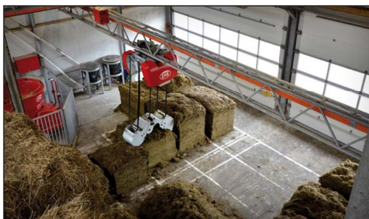
Úloha člověka v automatizovaném systému spočívá v naskladňování kuchyně, kam se ukládají objemové komponenty v řezaných blocích nebo kontejnerech
